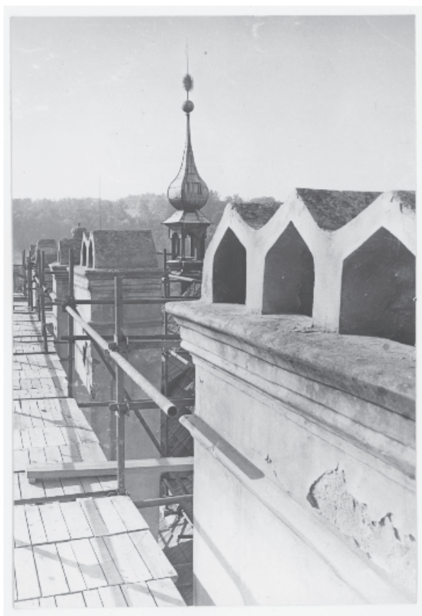
Pohled na řadu komínů během rekonstrukce budovy muzea v roce 1979.
